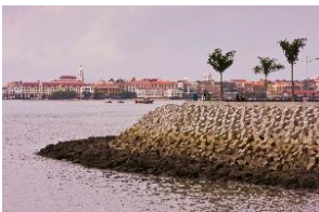
Rip Rap Revetment
