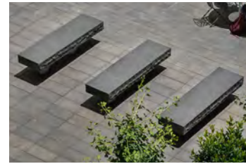
19a Alternative Barrier: Stone Block
