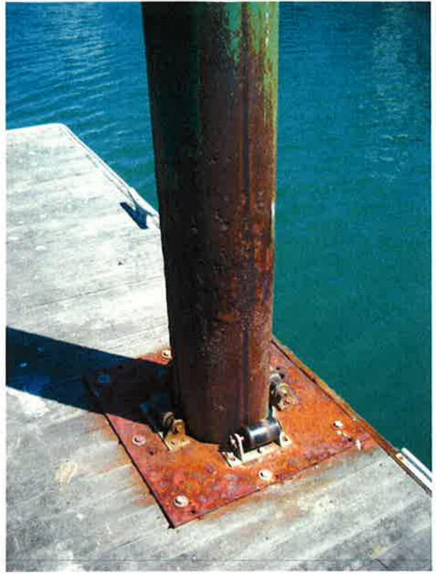
08-Steel Guide Pile
