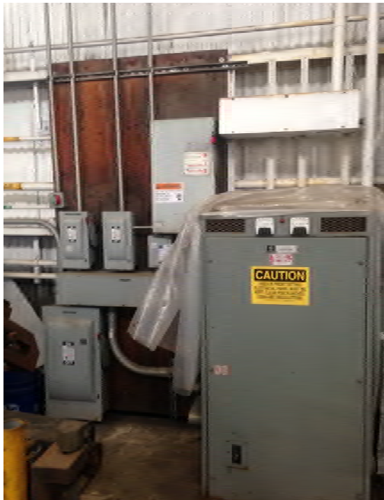
Figure 24. Rectifier
